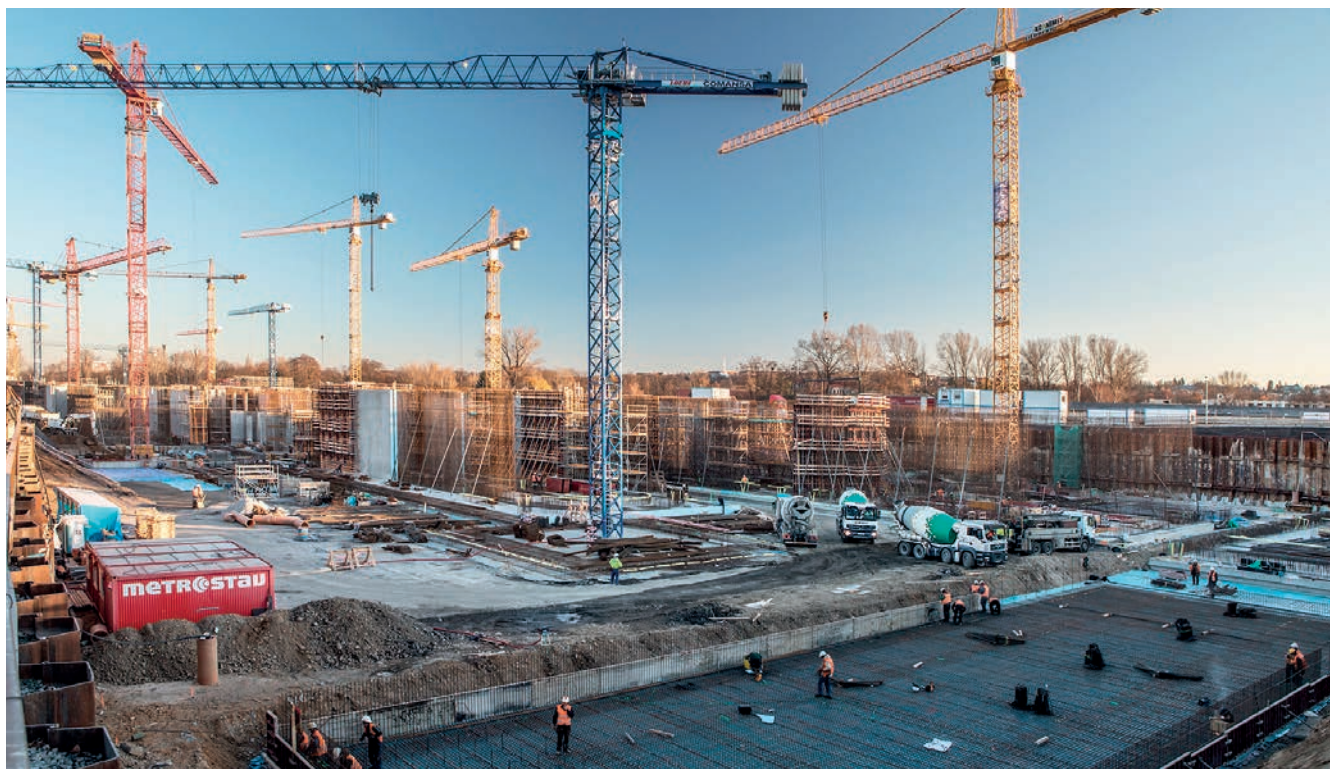
Pohled na staveniště ÚČOV
