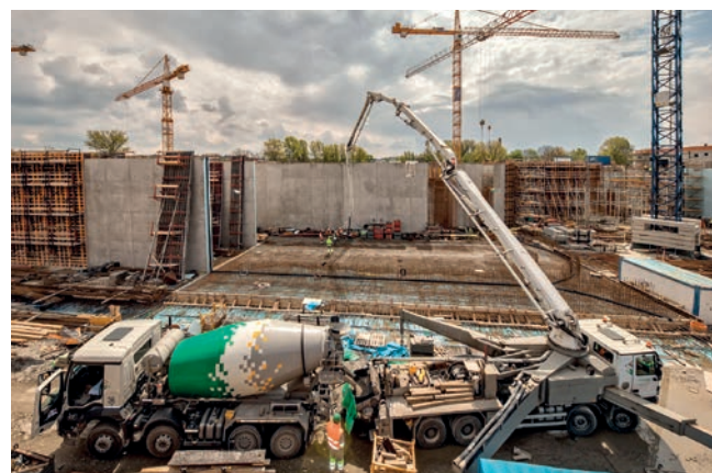
Rozsah činností byl značný. Dispečer musel zajišťovat spolupráci betonáren, zajistil čerpadla, automodifikáče, odběry kontrolních vzorků a kontinuální dodávky jednotlivých složek
