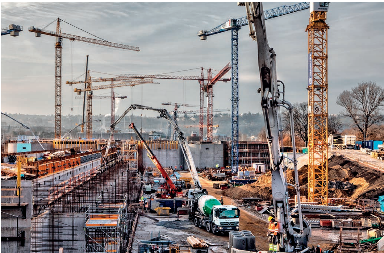
V době nejvyššího stavebního nasazení na stavbě fungovalo až 18 jeřábů
