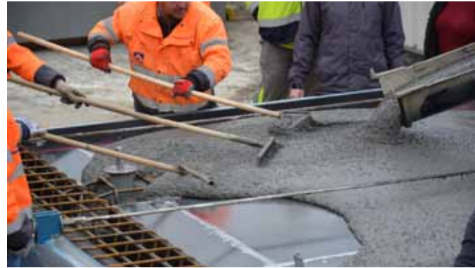
Ultra vysokopevnostní beton TOPCRETE
