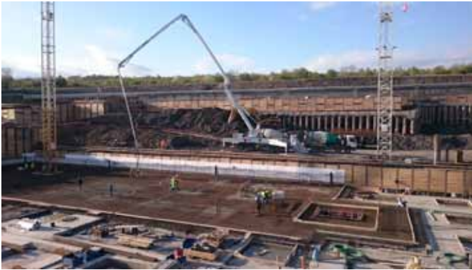
Stavba nové pobočky ČSOB Radlická – betonáž bílé vany z PERMACRETE
